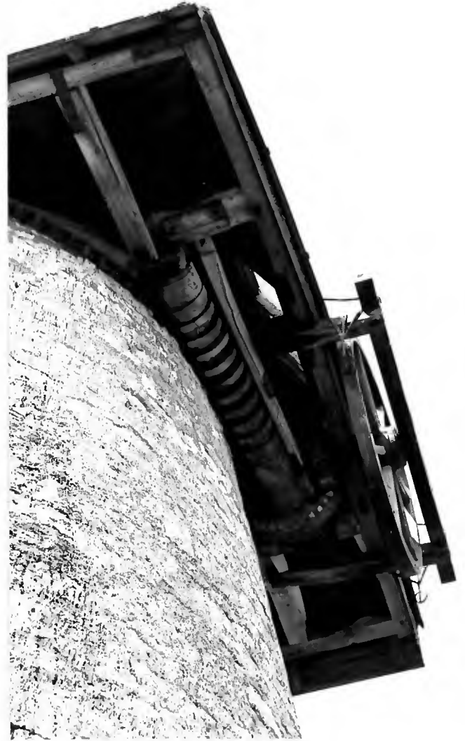
Bembridge mill: winding gear
