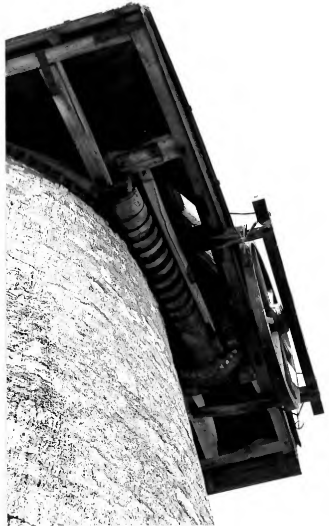
Bembridge mill: winding gear
